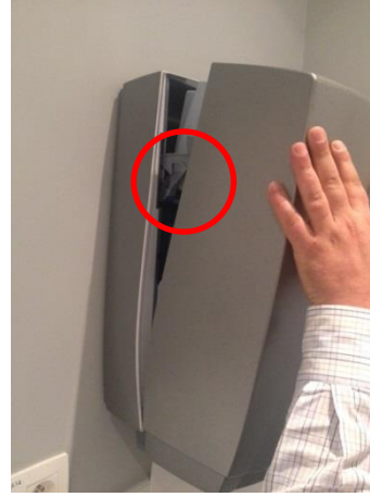
20. Faites attention de refermer le couvercle de façon bien droite pour que les fixations de fermeture ne puisse pas se déformer.
