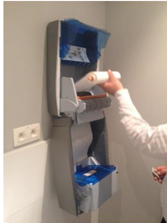
11. Enlevez la broche avec le rouleau de papier utilisé.
