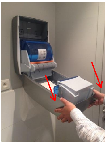
3. Faites basculer le couvercle doucement, sans cogner le mur.
