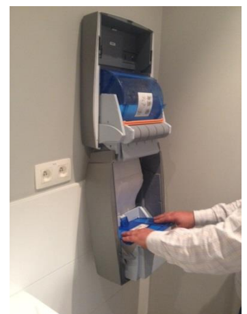
9. Sluit de klep van de cassettehouder.
