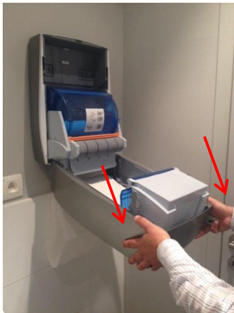
3. Laat de kap zachtjes zakken met beide handen en zorg dat de kap niet tegen de muur slaat
